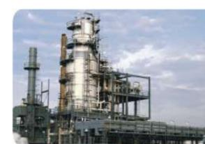
당사는 증류탑 상부의 고온 및 넓은 pH 변동에서도 안정적인 필름을 형성하여 주요 부식원으로부터 시스템 내부를 보호하도록 제조된
