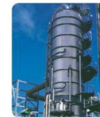
当社の露点中和剤は、露点位置からオーバーヘッドブーツ水セクションまで一貫した pH プロファイルを維持することによって、分留塔のオーバーヘッドシステムを水による腐食から保護します。
