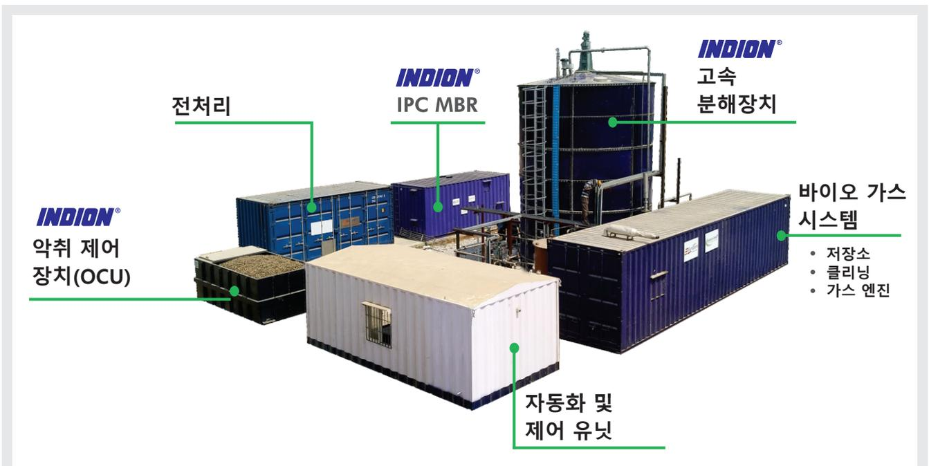
위의 플랜트는 커뮤니티 주방에서 발생하는 약 900kg/d의 유기성 폐기물과 일 2 - 6m<sup>3</sup>의 하수 슬러지를 처리하도록 설계되었습니다. 최대 용량으로 20kW/h의 전기 에너지와 1.35톤/d의 유기질이 풍부한 비료를 생산합니다. 호텔, 주택 및 기관에서 발생하는 다양한 용량의 폐기물을 처리하기 위해 유사한 모듈형 시스템을 사용할 수 있습니다.
