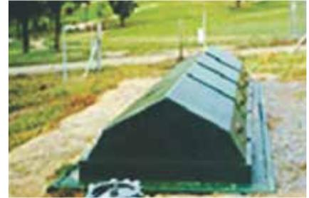
Комплексные установки по очистке сточных вод нового поколения INDION — уникальное сочетание технологий ламеллярного пластинчатого осветления и аэрации в готовой к эксплуатации предварительно собранной установке для очистки сточных вод с исключительной производительностью и эффективностью.
