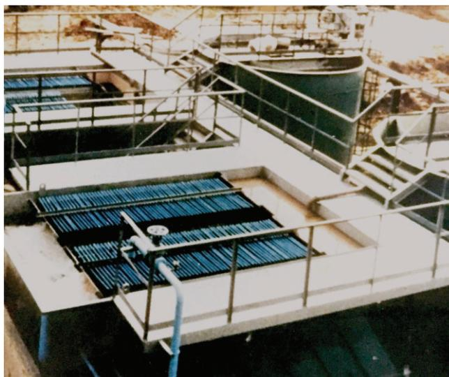
Установка в Индии 2 x 100% очистителей пластинчатого типа с резервуарами для флокуляции. Каждый очиститель рассчитан на максимальную скорость потока 240 м3/ч
