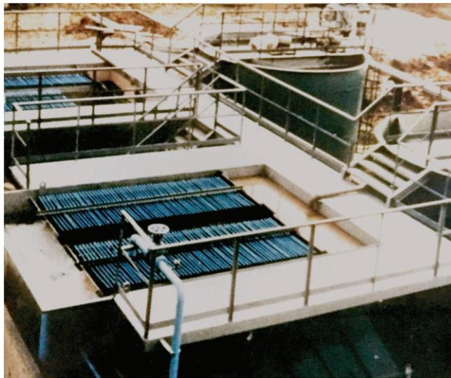
インドでの設置内容: 2台の100%ラメラクラリアファイアとフロック形成タンク。各クラリアファイアは最大流量 240 m<sup>3</sup>/hに対応しています。
