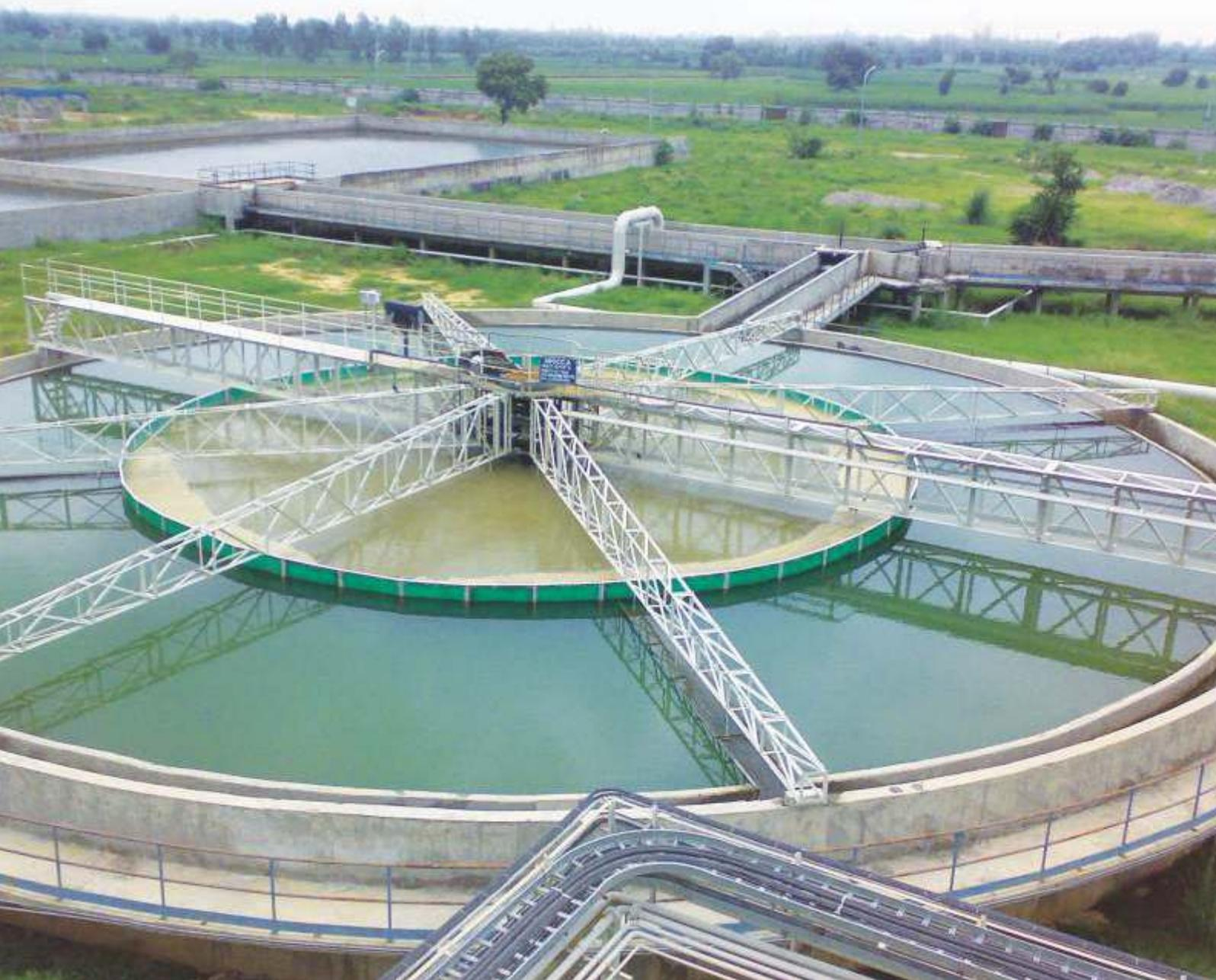
Высокопроизводительный осветлитель с взвешенным слоем осадка INDION® (HRSCC) - высокоэффективный осветлитель, устройство которого предусматривает внутреннюю рециркуляцию твердых частиц. Таким образом оптимизируется потребление химикатов, что делает данную установку более экономичной, чем обычные осветлители.
