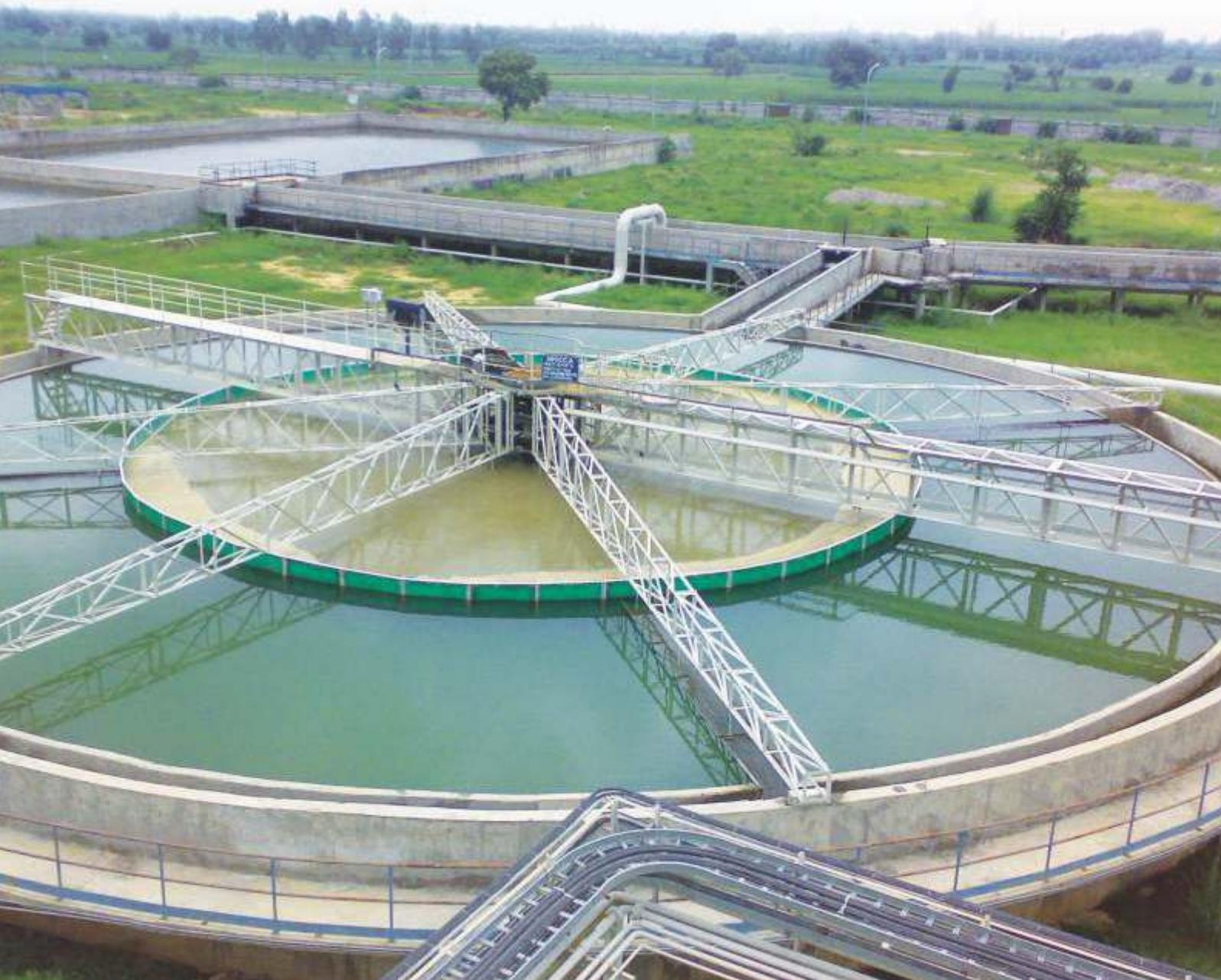
INDION® 高効率固形物接触洗浄器 (HRSCC) は、内部固形物再循環設計を組み込んだ高性能洗浄器であり、化学薬品の消費を最適化し、従来の洗浄器よりも経済的です。
