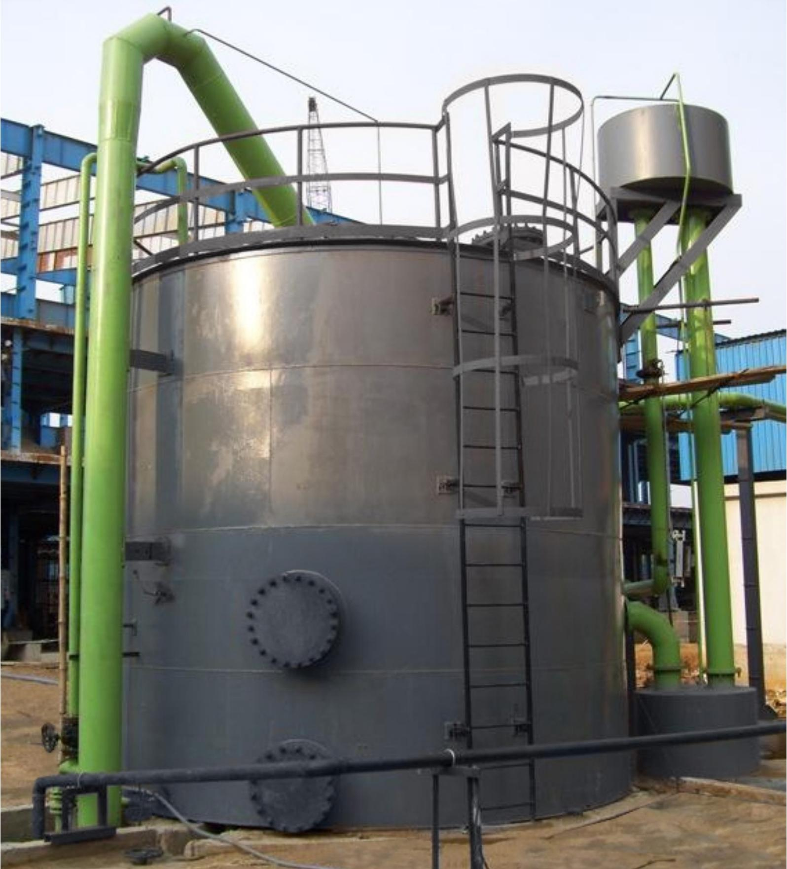
Компания Ion Exchange, лидирующая на протяжении более пяти десятилетий в области комплексного управления водными ресурсами, предлагает автоматический бесклапанный гравитационный фильтр INDION (AVGF). Это высокоэффективный автоматический фильтр, который работает без единого клапана, насоса обратной промывки, регулятора расхода или других приборов. В AVGF отсутствуют движущиеся части.
