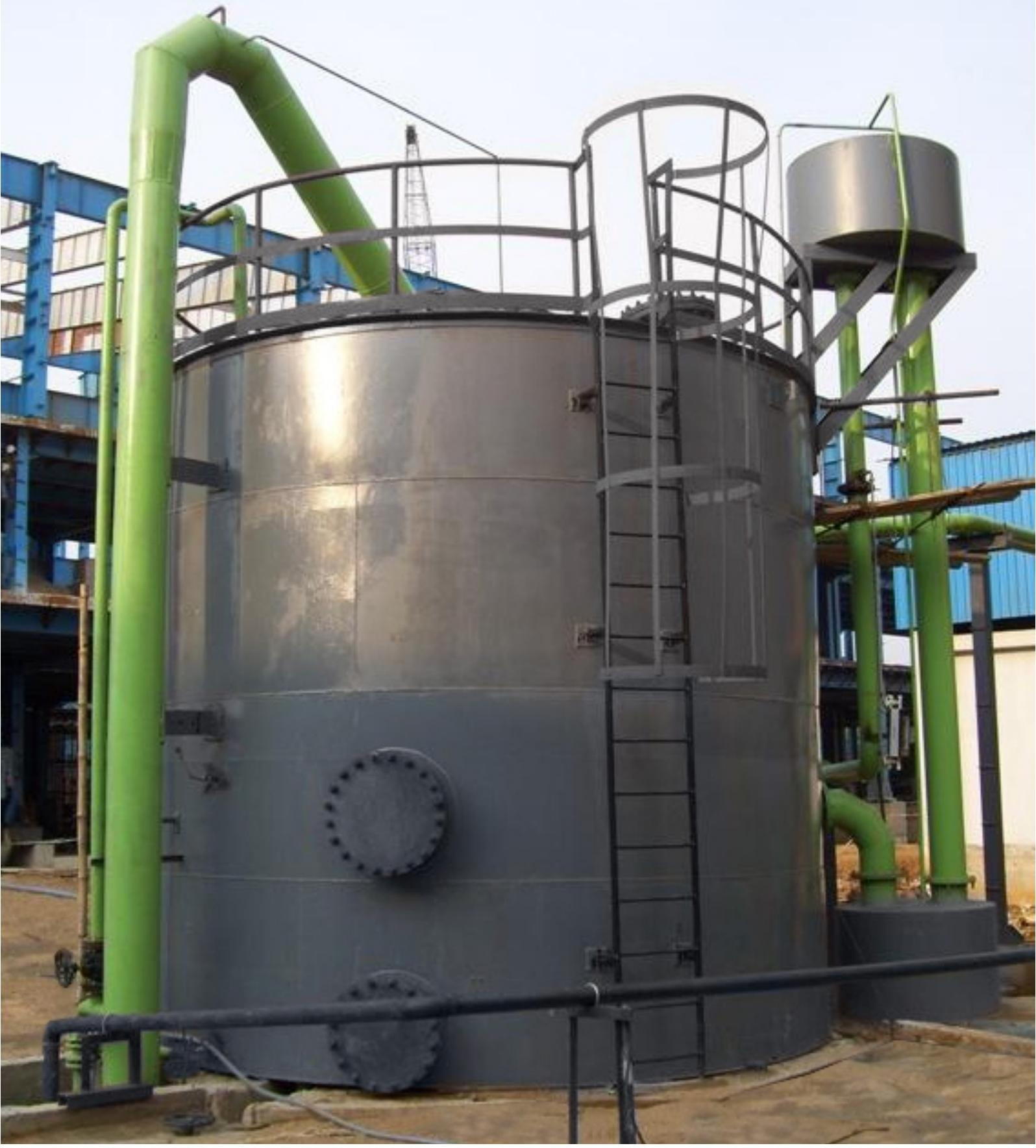
Ion Exchangeは、50年以上にわたり排水・管理の総合的パイオニアおよびリーダー企業として、INDION自動バルブレス重力フィルター (AVGF) を提供しています。AVGFは、単一のバルブ、逆洗ポンプ、流量コントローラー、その他の設備なしで動作する非常に効率的な自動フィルターです。AVGFには可動部品がありません。インドでは、当社の設置機器が肥料、石油化学、電力産業で大いに活躍しています。
