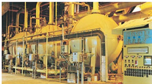
Unidades de purificação de condensado
