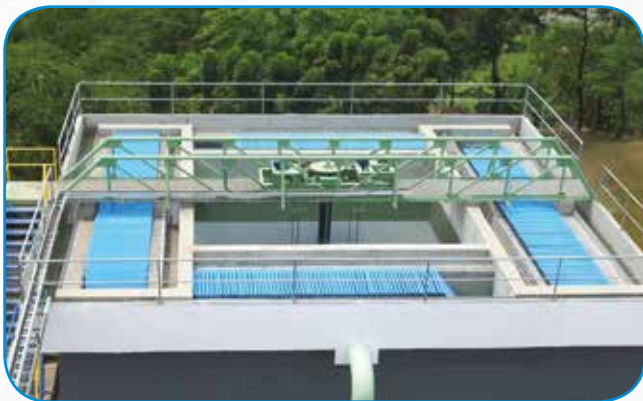
Clarificador de contacto de sólidos de taxa ultra alta (UHRSCC)
