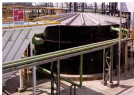
Reactor de medios fluidos (FMR)/ INDION Biorreactor de lecho móvil INDION (MBBR)
