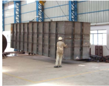
Impianto di fabbricazione e assemblaggio a Hosur, Tamil Nadu
