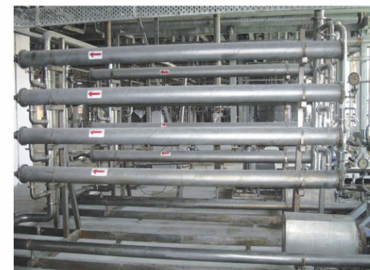
Unidade de ultra purificação de concentração de gelatina na indústria alimentar e de bebidas
