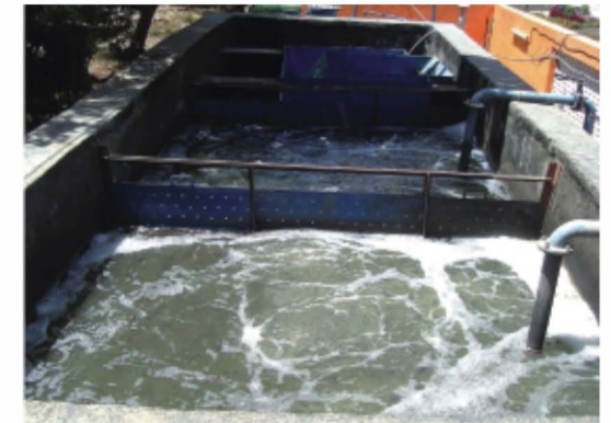
Reactor de medios fluidos para el tratamiento de aguas residuales y el reciclado de agua
