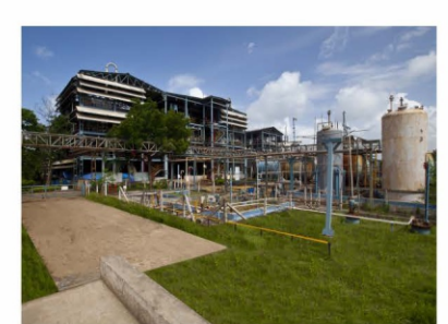
Unidad de fabricación de resinas en Ankleshwar, Gujarat
