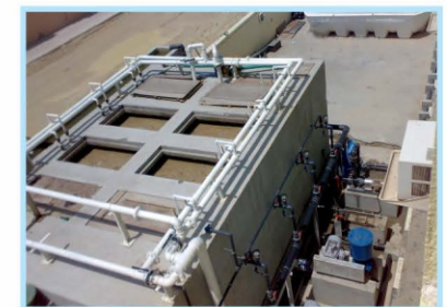
Biorreactor de membrana en complejo comercial
