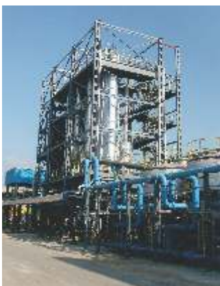
Evaporador multiefeitos
