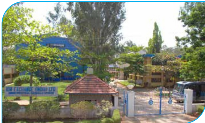
Usine de fabrication
