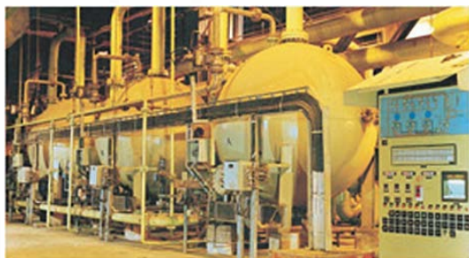
Unités de polissage des condensats
