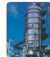
Nos neutralisants de point de rosée aident à protéger le système supérieur de la colonne de fractionnement contre la corrosion aqueuse, en maintenant un profil de pH uniforme, depuis le point de rosée jusqu'à la section de l'eau d'amorçage supérieure.
