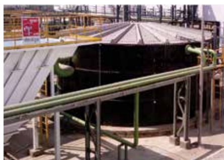
Реактор с псевдооживленной средой INDION (ППС) Биореактор с подвижным слоем INDION (БПС)
