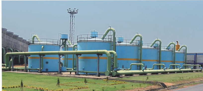
مرشحات التيار الجانبي في منشأة الصُّلب
