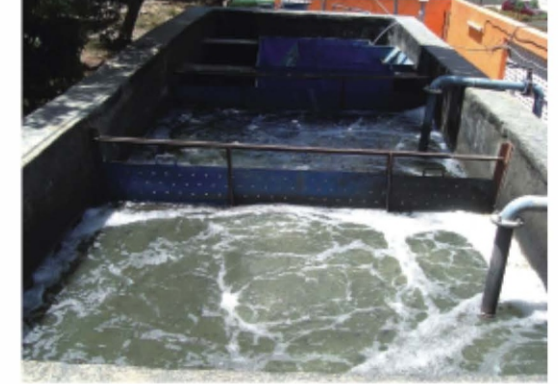
مفاعل وسائط مميعة لمعالجة مياه الصرف الصحي وإعادة تدوير المياه
