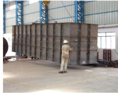
Fabrikations- und Montageanlage in Hosur, Tamil Nadu
