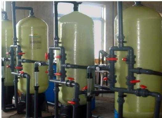
Impianto di rimozione dell'arsenico per il trattamento delle acque sotterranee
