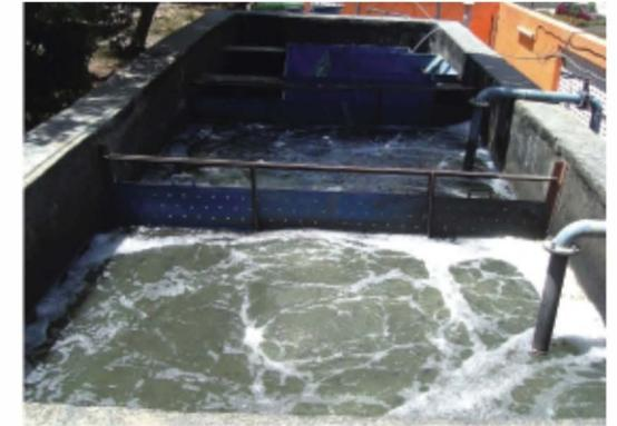
Reattore per mezzi fluidificati per Trattamento delle acque reflue e riciclaggio delle acque
