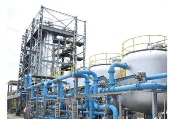
Sistema di scarico liquido zero presso impianto di gomma sintetica
