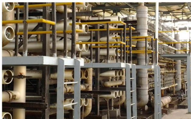
Osmosi inversa dell'acqua di mare (dissalazione) presso la centrale termoelettrica
