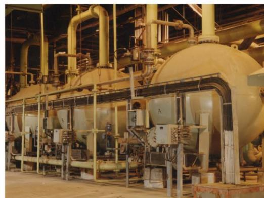
Unità di lucidatura della condensa per centrali elettriche
