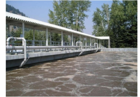
Traitement de l'eau potable pour une municipalité
