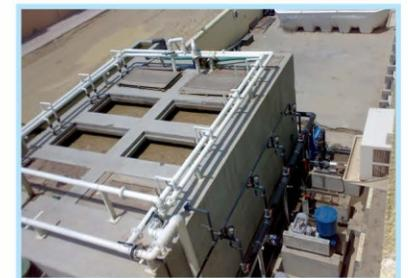
複合商業施設の膜生物反応装置
