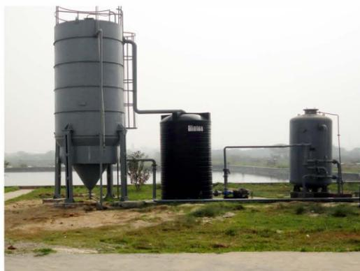
地表水処理用連続砂ろ過装置
