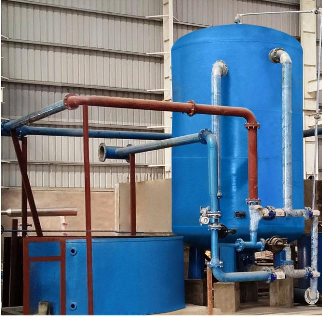
Indion Industrial Downflow Softener عبارة عن وحدة تعمل يدويًا ومصممة خصيصًا للاستخدام الصناعي. إنها سهلة التشغيل، واقتصادية في الصيانة، وتستخدم على نطاق واسع في الصناعة.
