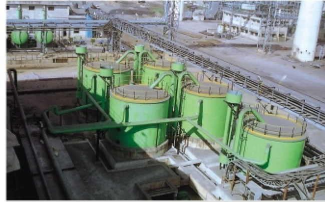
向Bhushan Steel提供的部分水处理系统和Strips有限公司
