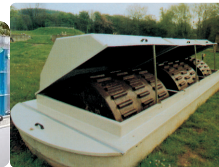
INDION新世代パッケージ汚水処理プラント(NGPST)
