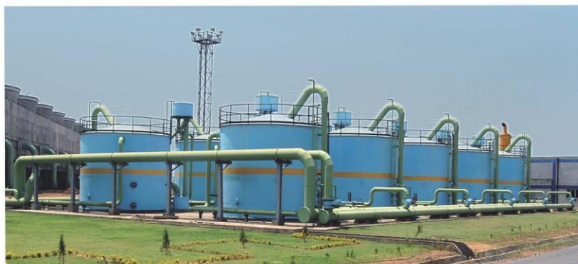
钢铁厂的侧流过滤器
