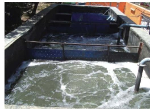
用于污水处理和回收利用的流化介质反应器用于污水处理和回收利用
