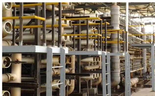
火力发电厂海水反渗透 (淡化) 设备
